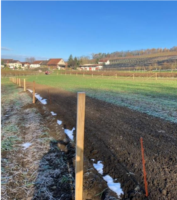
Der Schnee in dem ausgehobenen Graben bleibt länger liegen, und verbildlicht gut, wie sich zukünftig dort das auch das Regenwasser sammeln wird. (Quelle: Jürg Strauss)
